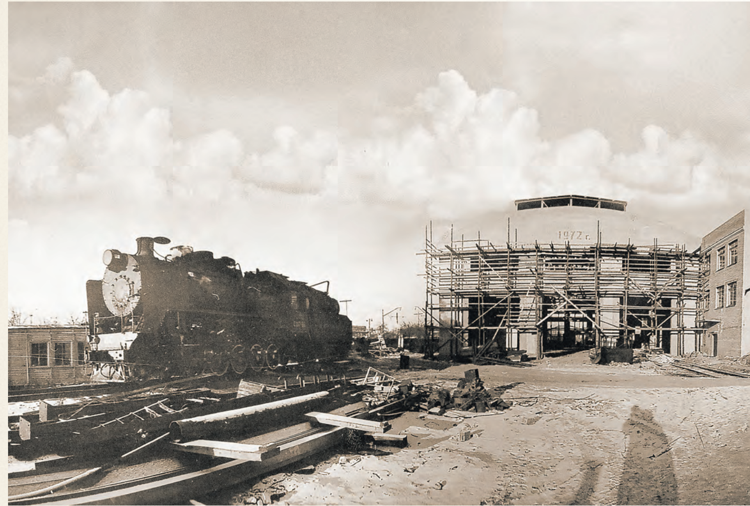
Строительство одного из цехов в моторвагонном депо в 1972 году.
