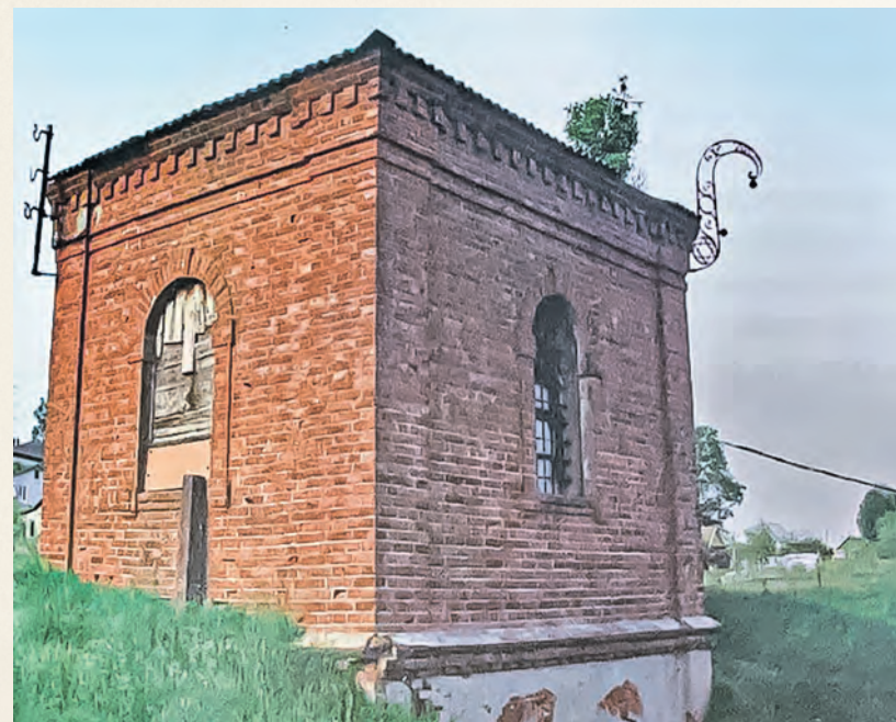
Водонасосная станция фабрики Днепропольская мануфактура.
