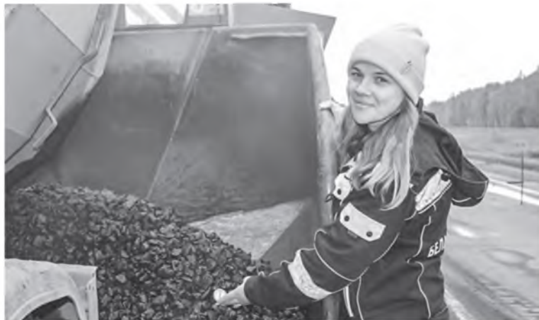
Инженер по качеству ДСУ № 19 Речицы Марианна Черношей контролирует соблюдение технологии укладки дорог.
